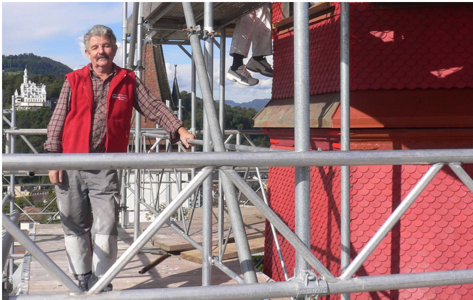
Dachdeckermeister Walter Würsch auf dem Baugerüst des Wachturmes
