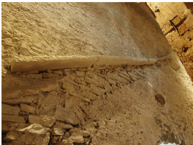
Letzte Spuren des Pulldachs : Der sogenannte Wasserschlag leitete das Wasser von der Wand auf das Dach ab.
