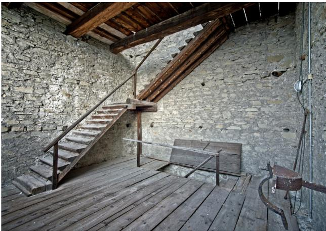
Originaler Zustand des Turminnern mit Balkenlagen, Blocktreppen und roh belassenem Mauerwerk mit Löchern der Gerüststangen
